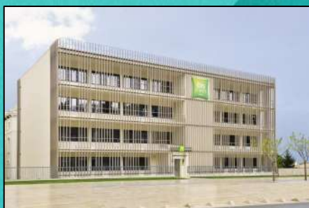
Hôtel Ibis Style Centre 1 Bis Av. Saint-Martin, 26200 Montélimar, France +33 4 75 46 46 46
